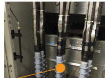
Switchgear Sensor: TEM
